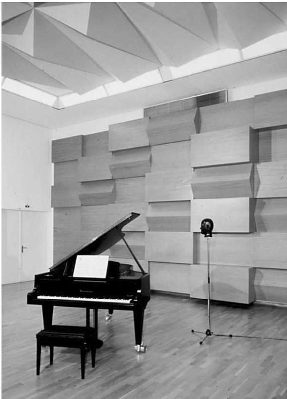
Selbstverständlich sind eine Fülle von strukturierten Wand- und Deckenformen denkbar, welche Schall analog Abb. 2 streuen. Regelmässige Strukturen sind dabei zu vermeiden. Je unregelmässiger strukturiert die Flächen sind, desto gleichmässiger ist die Streuung. Die wirkungsvollsten Strukturen sind nach mathematischen Gesetzen gestaltet (Schröder-Diffusoren, Prinzip: siehe Abb. 4).
