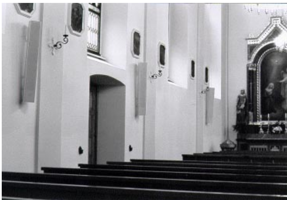
Abb. 6 Lautsprecherzeilen in der Kath. Kirche Zufikon: Starke Richtwirkung bei guter Klangqualität.
