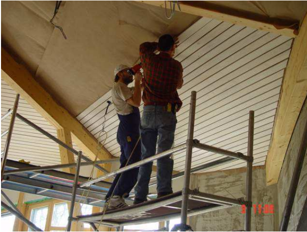
Abbildung 5: Einbau der Akustikdecke durch die Schülern. Bildquelle: http://www.rsszo.ch/
