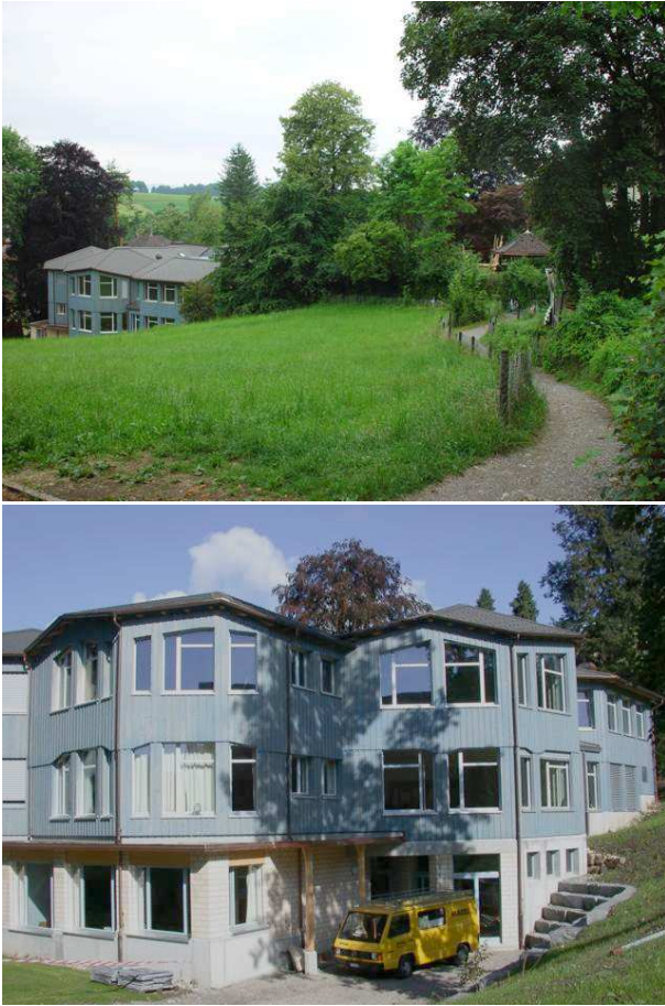
Abbildung 3: Schulhaus Rudolf Steiner Schule Zürcher Oberland, Wetzikon, Aussenansicht. Bildquelle: http://www.rsszo.ch/
